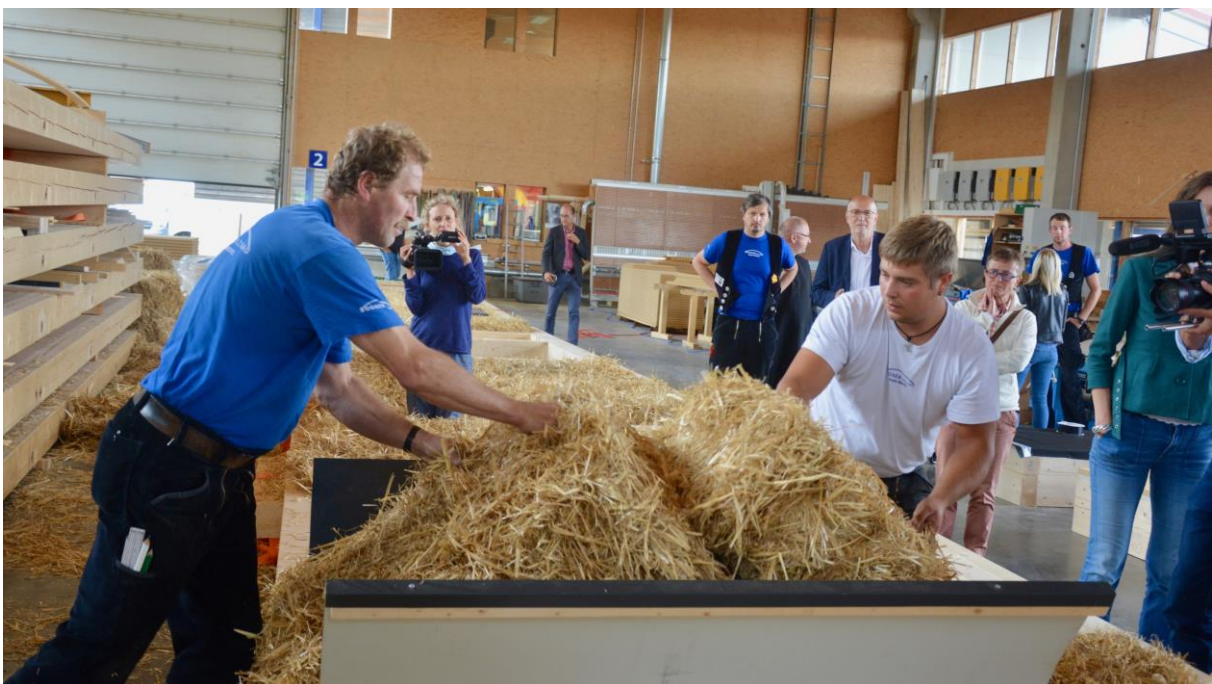
Bildunterschrift: Fachgerechter Strohballeneinbau in der Zimmerei Holzbau Bogner GmbH. Die Mitarbeiter bauen Strohballen aus kloster eigenem Biostroh in vorgefertigte Wandmodule aus kloster eigenem Holz ein. Foto: Lorenz Märtl
